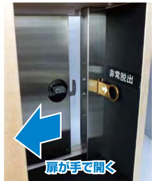
矢印方向にレバーを引けば施錠装置の受け部分が解除され、扉は手で開くことができます。復帰はレバーを元に戻すだけです。レバーを押せば『カチッ』としたバネによるロック感が使用者に伝わる設計も可能です。『非常脱出』の表示の側に蓄光のイラストを付けることも可能。
